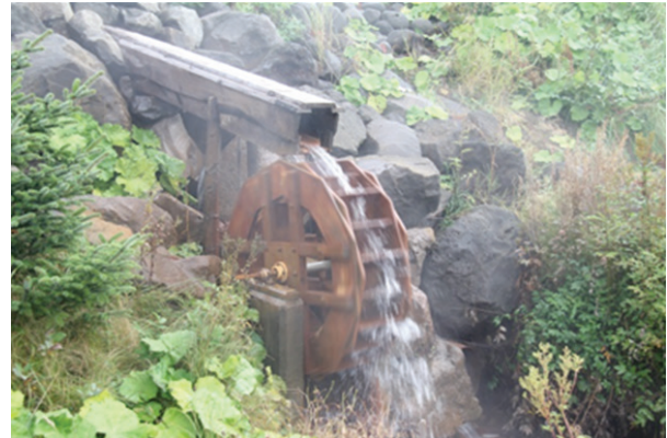
Mała elektrownia wodna
