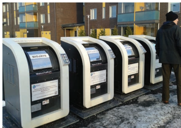
Pneumatyczne pojemniki na różne rodzaje odpadów w dzielnicy Vuores
