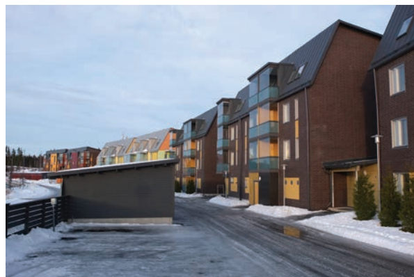
Murowane i drewniane bloki mieszkalne w dzielnicy Vuores (Tampere)
